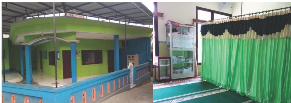
Gambar 3. Sebagian hasil dokumentasi kondisi eksisting masjid
