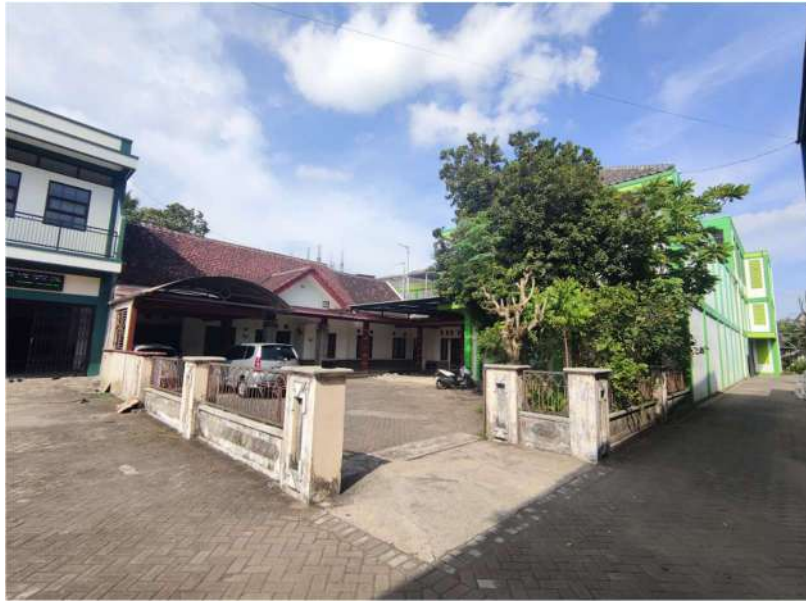
Gambar 7: kondisi pagar dari samping dan pintu masuk
