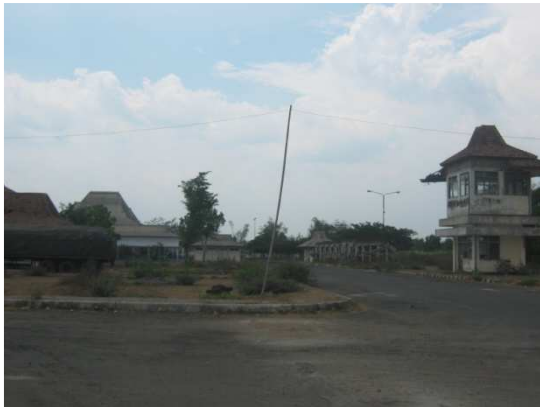
Gambar 1. Kondisi fasilitas bangunan yang rusak parah akibat tidak difungsikan dan tidak terawat
