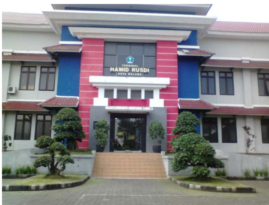
Gambar 1. Bagian depan gedung utama terminal Hamid Rusdi
