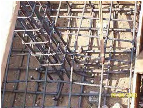
Gambar Pembuatan rakitan tulangan pelat
