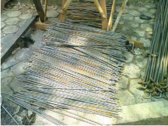
Gambar Persiapan tulangan untuk pondasi plat setempat
