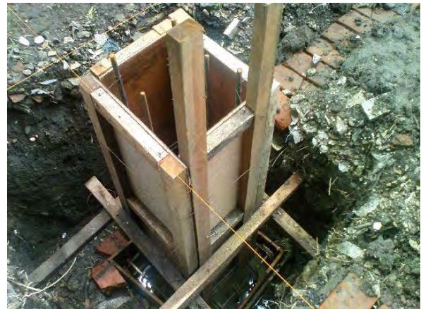
Gambar Bekisting cor beton untuk pondasi
